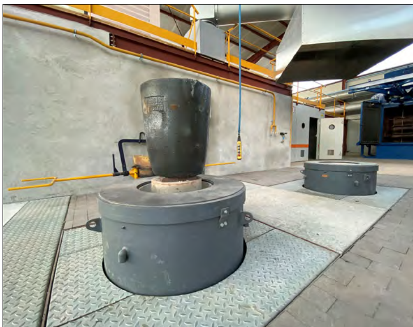
Photo 1 : Four à induction de type « push-out »
