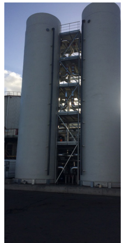
Cuves de stockage eau chaude
